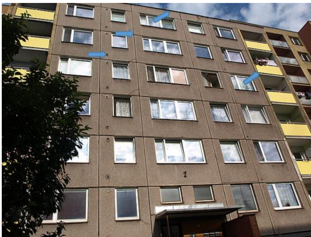
Obr. 37: Nezateplené panelové domy mohou být útočištěm netopýřů. Modré šipky ukazují možné úkryty: mezi panely, v dutinách kolem balkónů, ve větracích otvorech.
