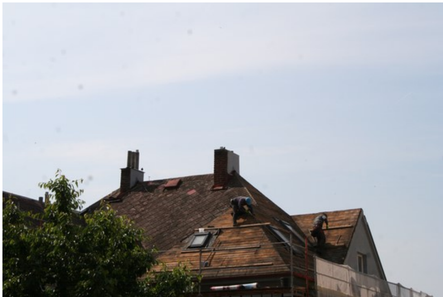
Obr. 8: Dům Beckovského 2514 při rekonstrukci střechy, kavky hnízdící v komíně zrovna vyváděly mladé.
