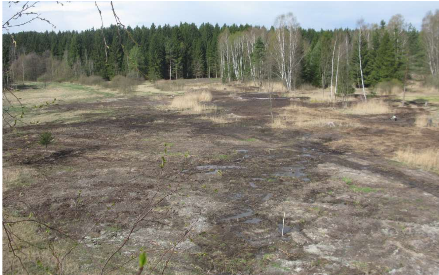
Plocha po vykácení, vytrhání pařezů a zahnutí odvodňovacích příkopů
