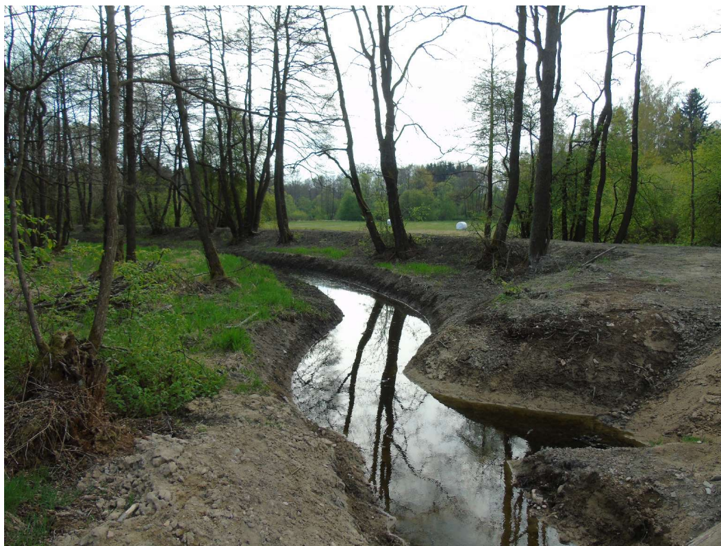
Upravené koryto přítoku rybníka Loch po odstranění opevnění (4. 5. 2022, D. Kodetová)
