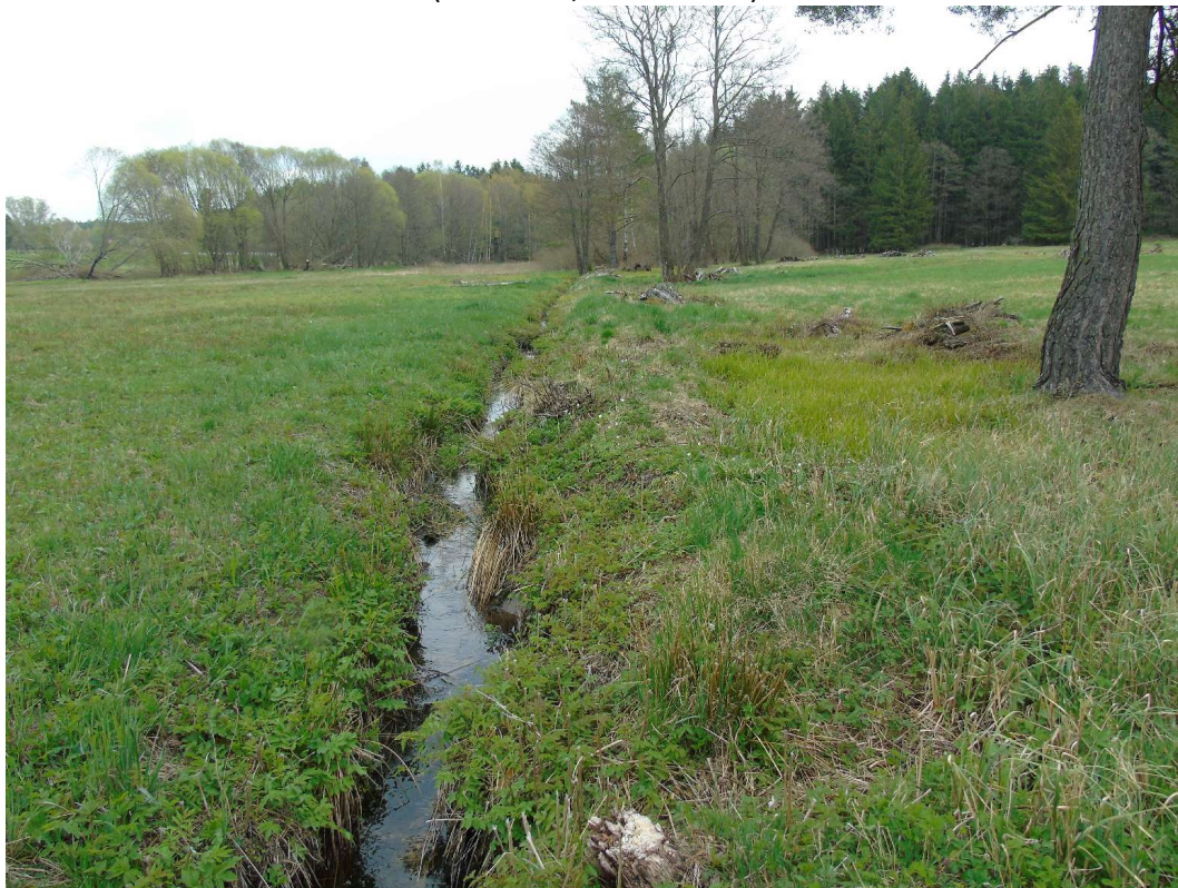
Napřímená zahloubená strouha s valem odvodňující louky nad Horním Ratajským rybníkem (4. 5. 2022, D. Kodetová)
